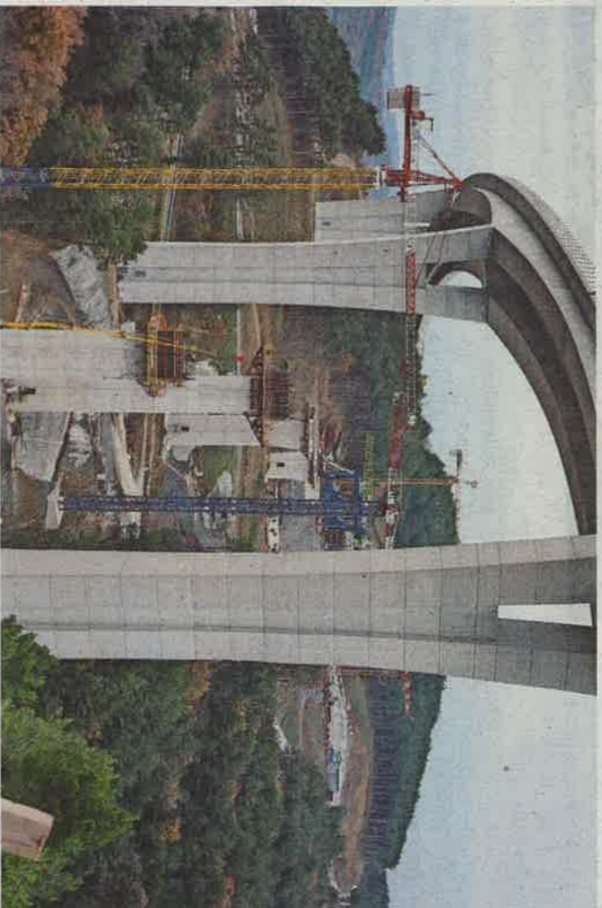
Slebri viadukta Gabrovica so visoki od 13 do 64 metrov, odvisno od lokacije. V prihodnjih tednih bodo nanje začeli "narivati" prekladno konstrukcijo.
