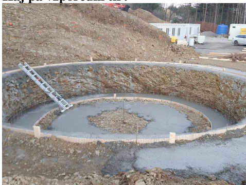
Pripravljalna dela za temelje na vodnjakih za viadukt Gabrovico. FOTO: Arhiv 2tdk
